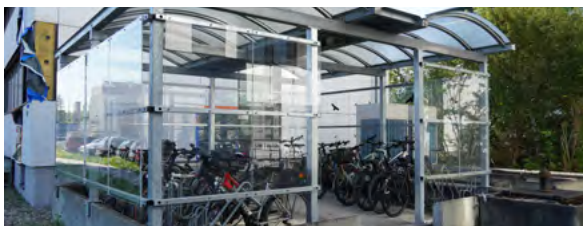
Abbildung 24: Unsere Fahrradstellplätze haben 2024 zusätzliche durchsichtige Seitenwände erhalten und schützen so die Räder vor Wind und Wetter.
