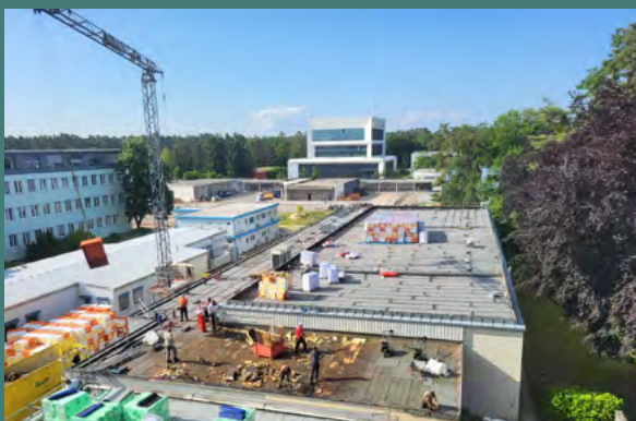
Abbildung 20: Sanierung der großen Dachfläche von Gebäude 241
