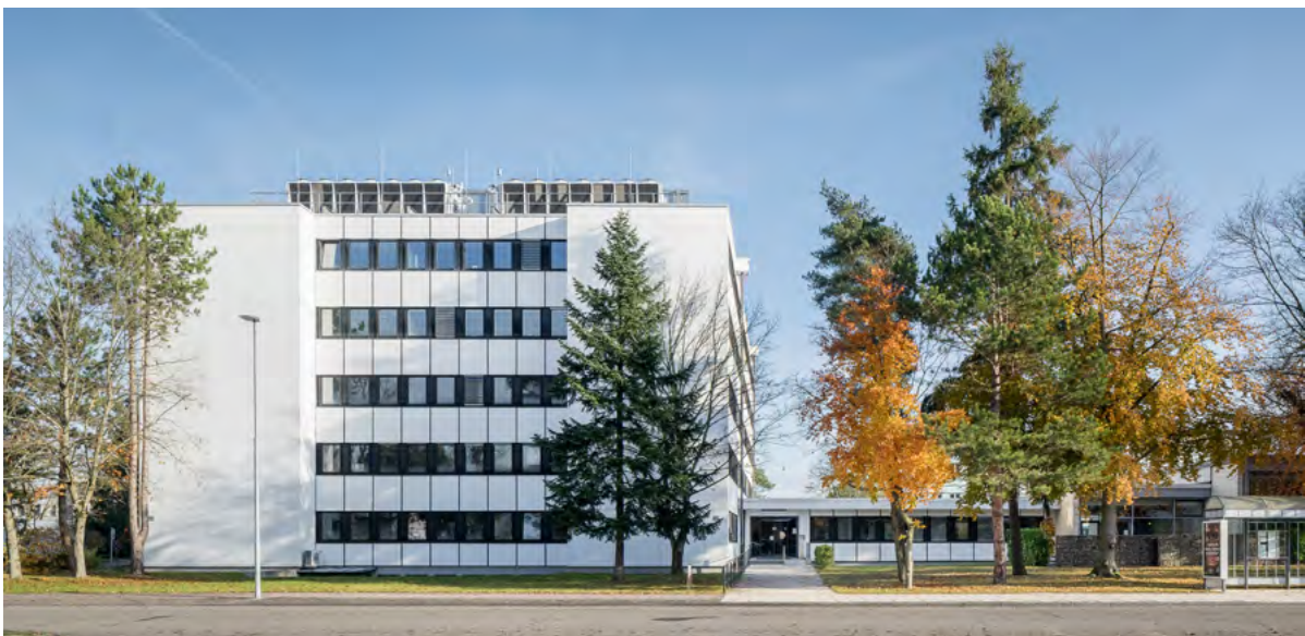
Abbildung 6: FIZ Karlsruhe – Leibniz-Institut für Informationsinfrastruktur, eines unserer Bürogebäude auf dem Campus Nord des Karlsruher Instituts für Technologie (KIT)
